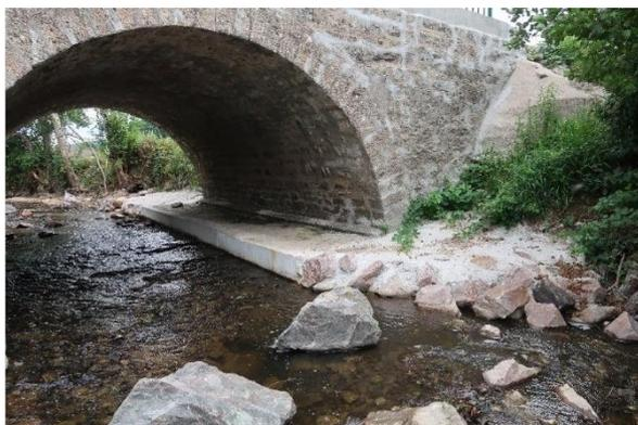
Figure 11 - Encorbellement en béton © D. Ierat – Vivre en côte d'or
