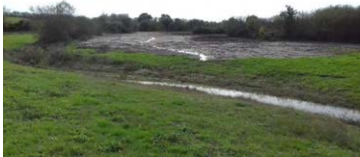
A gauche, le long de la haie l'ancien fossé rectiligne et profond ; plus à droite, le nouveau fossé méandrique, peu profond et « borgne » : non connecté au réseau (Cliché SAH octobre 2019).
