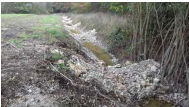
Création de redents dans le fossé de drainage pour réduire les vitesses de ruissellement, favoriser les temps de rétention (petites fosses) et d'épuration de l'eau ainsi que pour maintenir l'humidité des sols (Cliché SAH octobre 2019).
