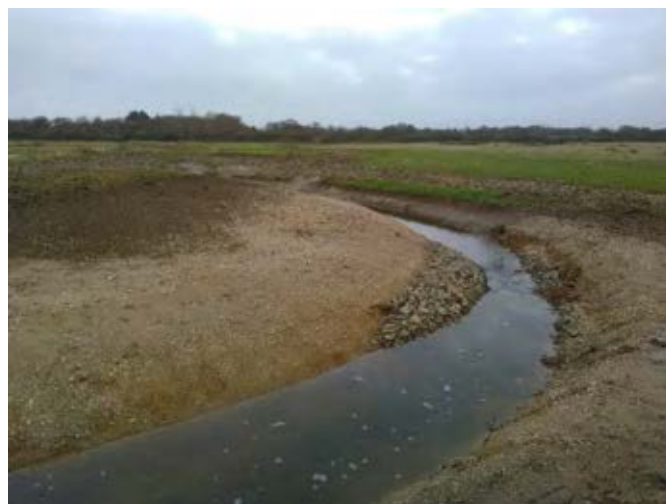
Recharge en amont de la Noultrie à gauche et reméandrage du ruisseau des Grandes Maisons à droite, décembre 2018 (clichés SMBB)
