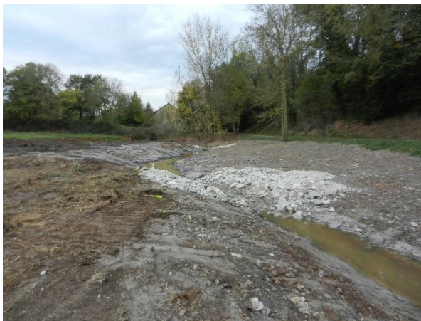
Reméandrage du Falleron à Saint Etienne de Mer Morte (novembre 2017) pendant la phase travaux- Cliché ADBVBB
